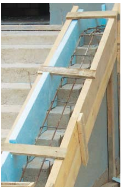
Рис. 1. Крепление плит.
