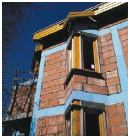
Существующая теплоизолированная оконная перемычка
